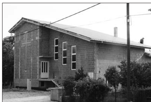
Nova crkvena zgrada nakon postavljenoga krovnog pokrova, lipanj 2009.
