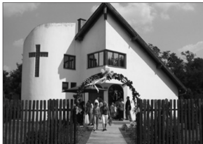
Zgrada BC Ljutovo danas
